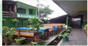
Gambar 4. Kondisi Area Tempat Duduk Setelah Pemeliharaan
